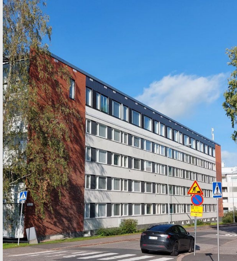
Katajaharjuntie 2-4 rakennuksen korottaminen
